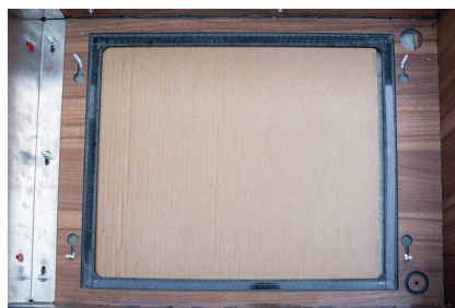
Banda aplicată pe conturul locașului.
